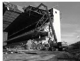
Bergsten Park St. demolition
